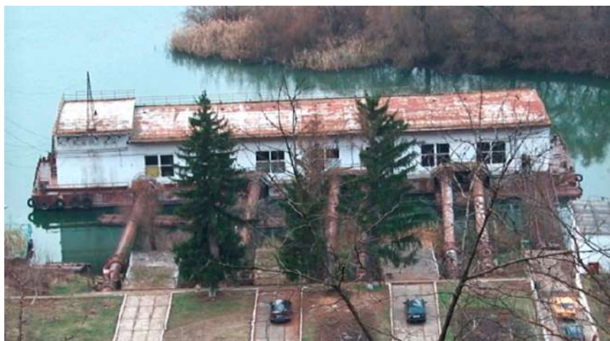
Рисунок 2. Насосная станция с. Выхватинцы (Основные насосы НС-1 находятся на отметке (-16,5) м и предназначены для непрерывной подачи речной воды в систему водоводов мелиоративного комплекса. Установленные насосные агрегаты обеспечивают суточную производительность насосной станции 27 000 м 3 )
